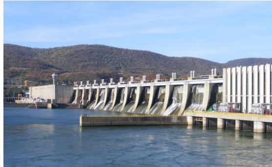
Barajul Porțile de Fier
